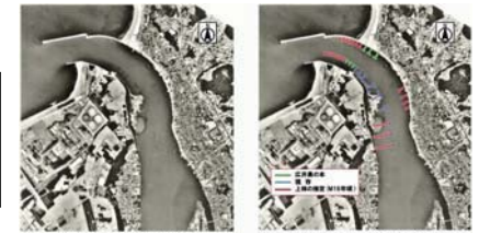
(a)空中写真(昭和55年撮影) (b)上流が堆積復元した当時のI型粗梁水制 図-10 エッシャー設計の九頭竜川河口の防波・導流堤(右岸)と粗梁水制(左岸)
