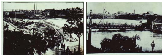
安治川橋 (現西区川口と福島区の中央卸売市場の間)
